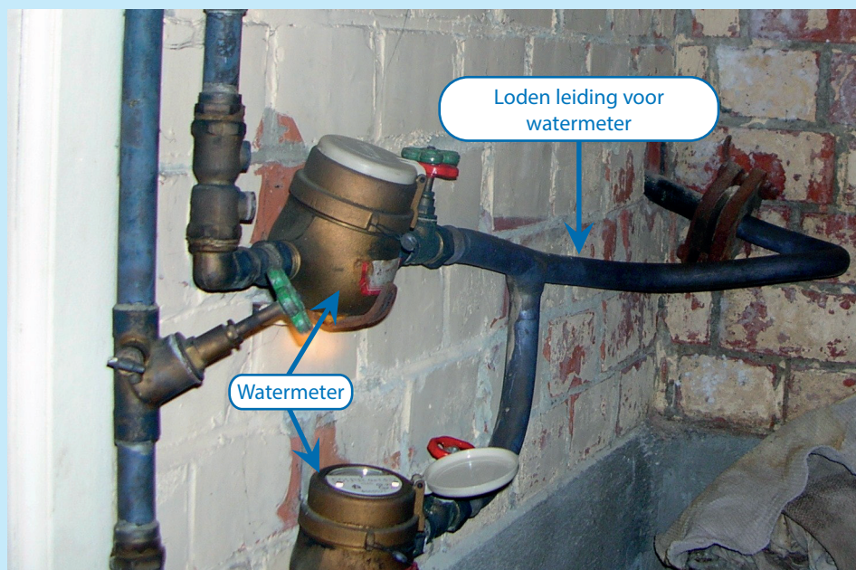
figuur 3: Loden leiding voor watermeter
