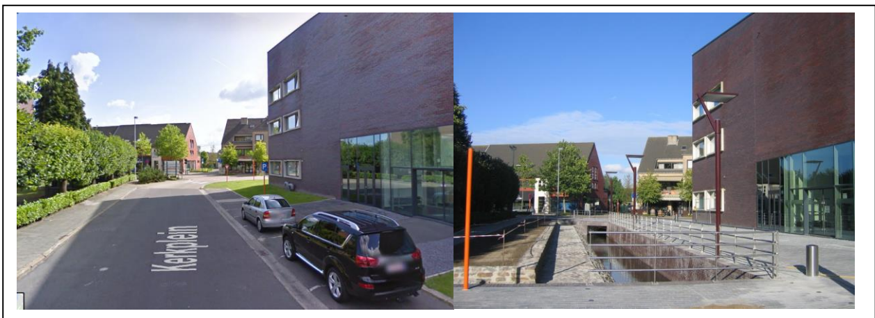
Figuur 6: Foto van ingekokerde Plaatsebeek (links) en opengelegde Kerkebeek (rechts) in het centrum van Zedelgem
