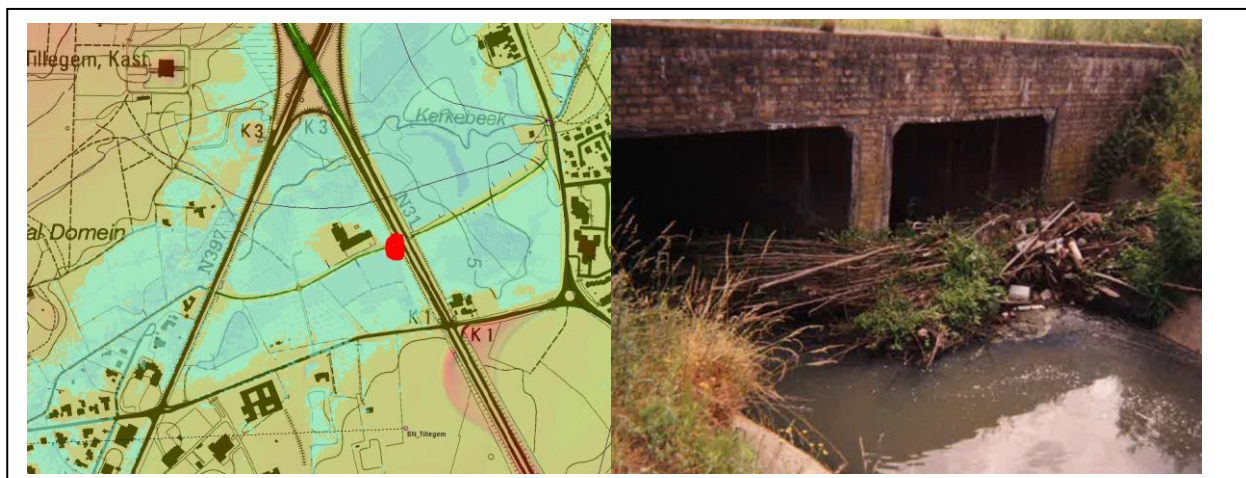
Figuur 17: Middenpijler met potentiële opstuwingswaterpeilen
