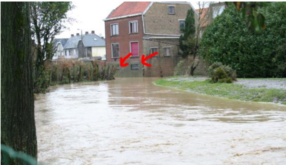
Figuur 19: Café The Bridge met aanduiding kelderramen
