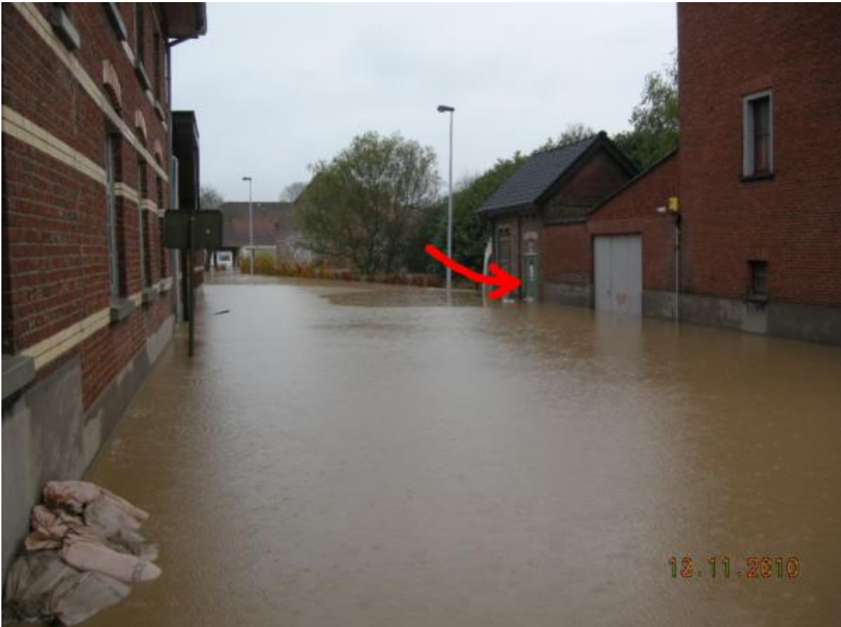
Figuur 20: Elektriciteitscabine Watermolenstraat
