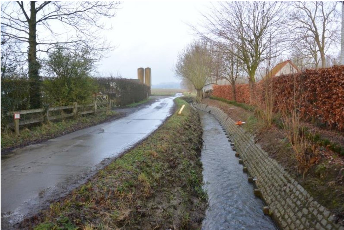
Figuur 24: de Groenstraat waar op de oevers een waterkering moet gerealiseerd worden
