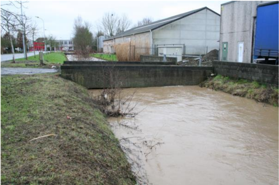
Figuur 4: Middelste brug, afwaartse kant
