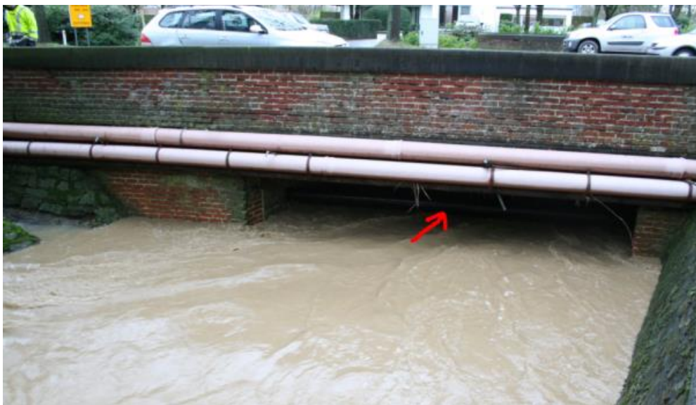
Figuur 9: Nutsleiding onder het brugdek N8 (opwaartse kant)
