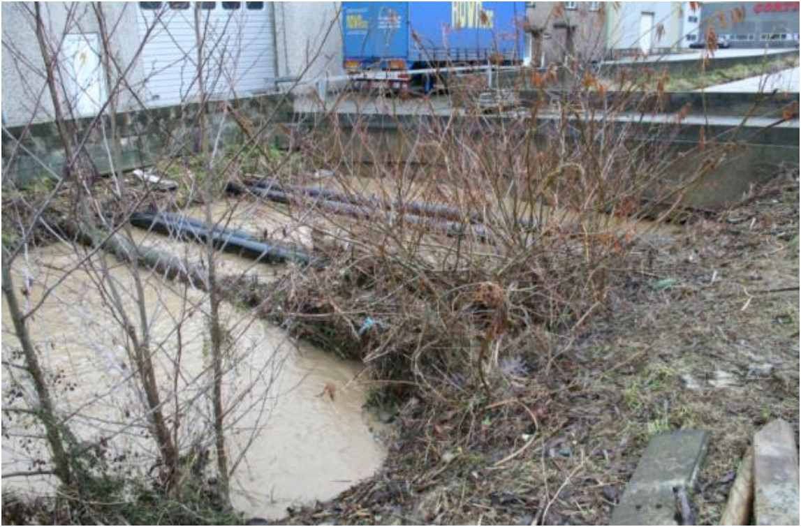
Figuur 5: Middelste brug opwaartse kant
