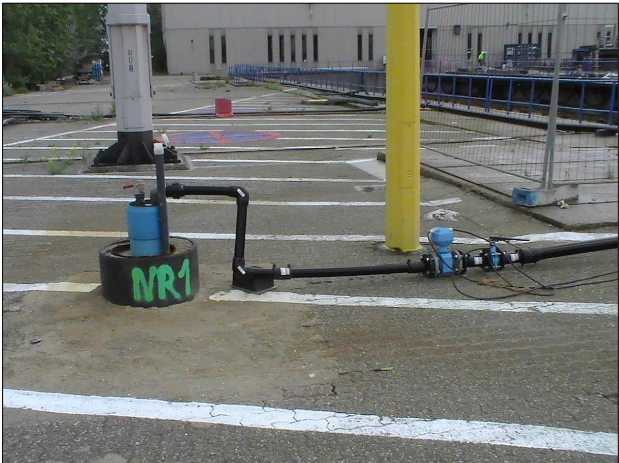
Figuur 38 uitvoering van een retourbemaling door middel van diepe infiltratie
