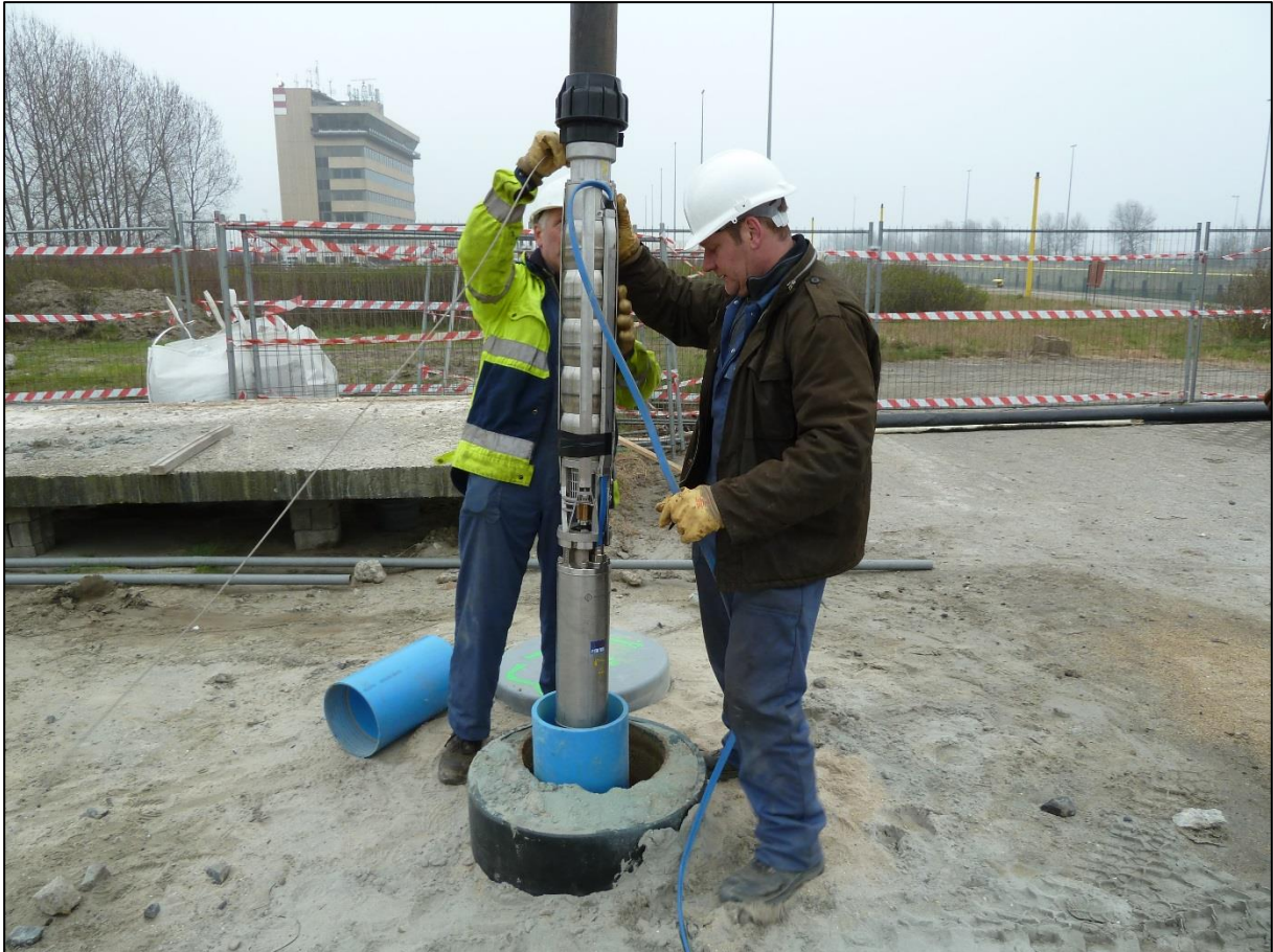
Figuur 31: plaatsing van een onderwaterpomp in een dieptebron met behulp van een kraan
