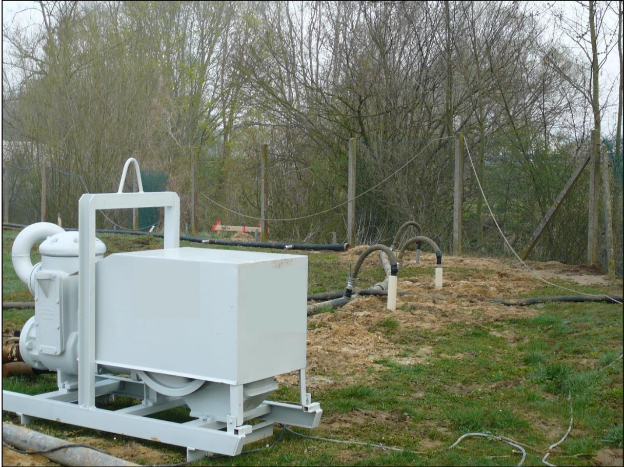
Figuur 25: uitvoering van een filterbemaling met zuigerpompen
