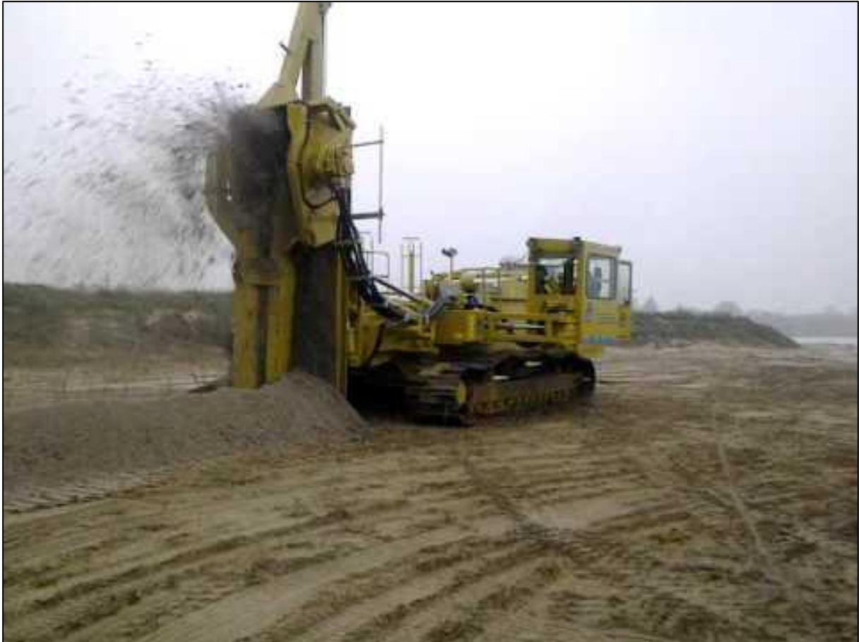
Figuur 20 kettinggraafmachine aan het werk
