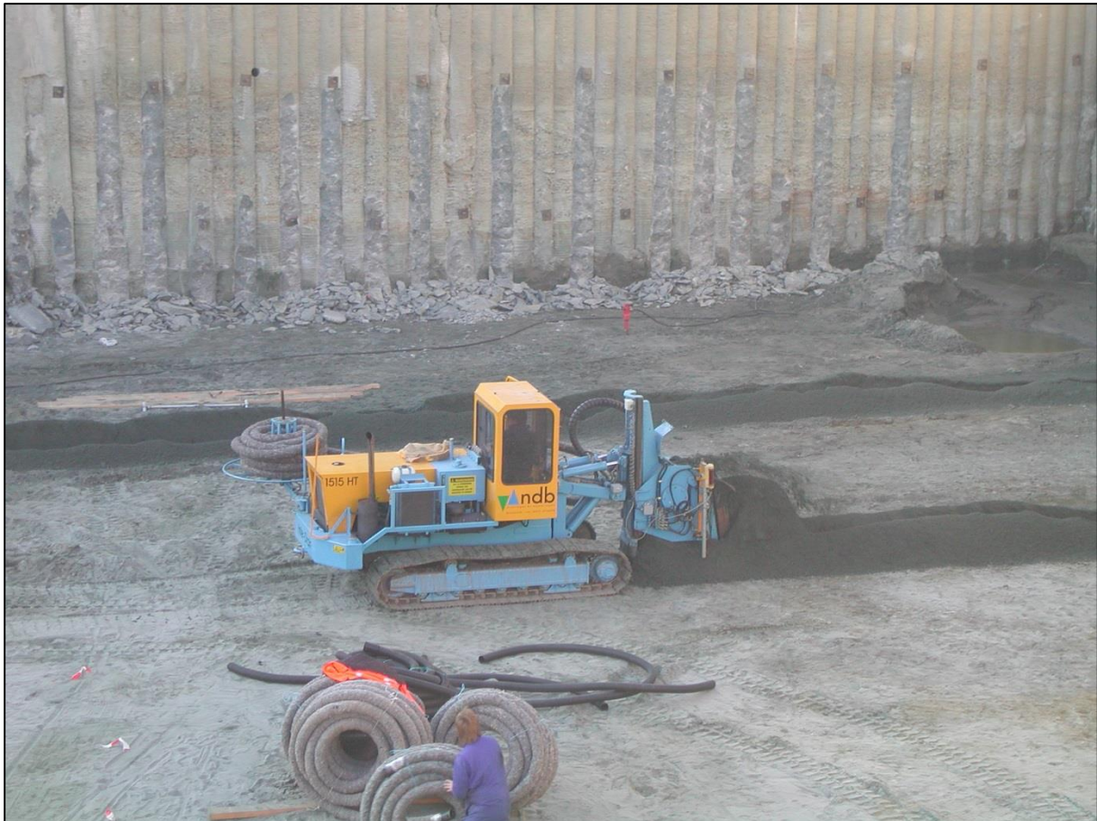
Figuur 21 trekken van een horizontale drain in een reeds gedeeltelijk uitgegraven bouwput
