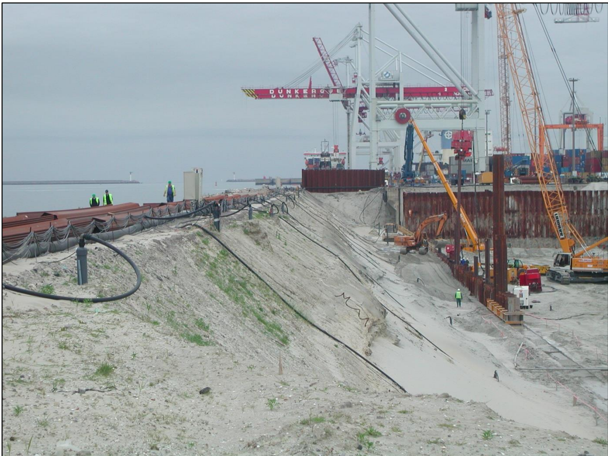
Figuur 32 uitvoering van een bemaling met dieptebronnen
