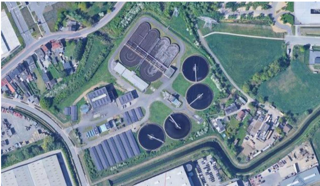
Figuur 9: Overzicht rioolwaterzuiveringsinstallatie in Grimbergen
