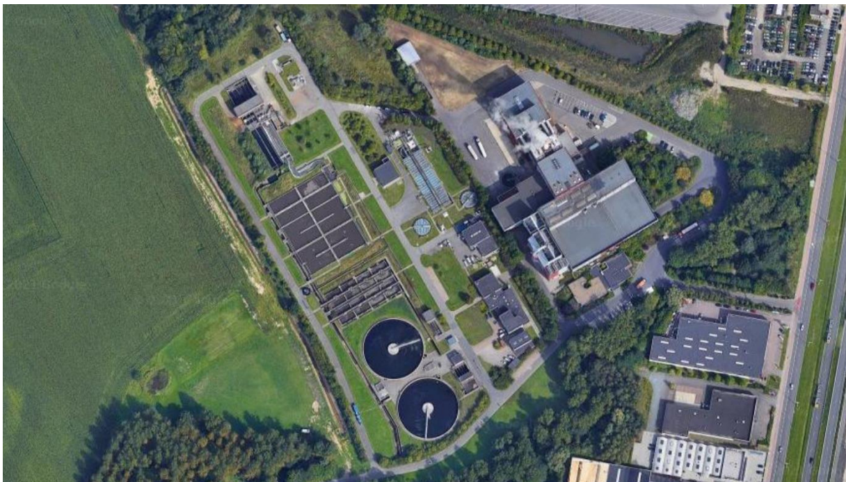
Figuur 2: Overzicht rioolwaterzuiveringsinstallatie in Aartselaar
