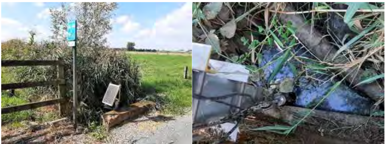
Figuur 13: Installatie van Nico+ nitraatsonde in de Hulstebeek in Hulste.
