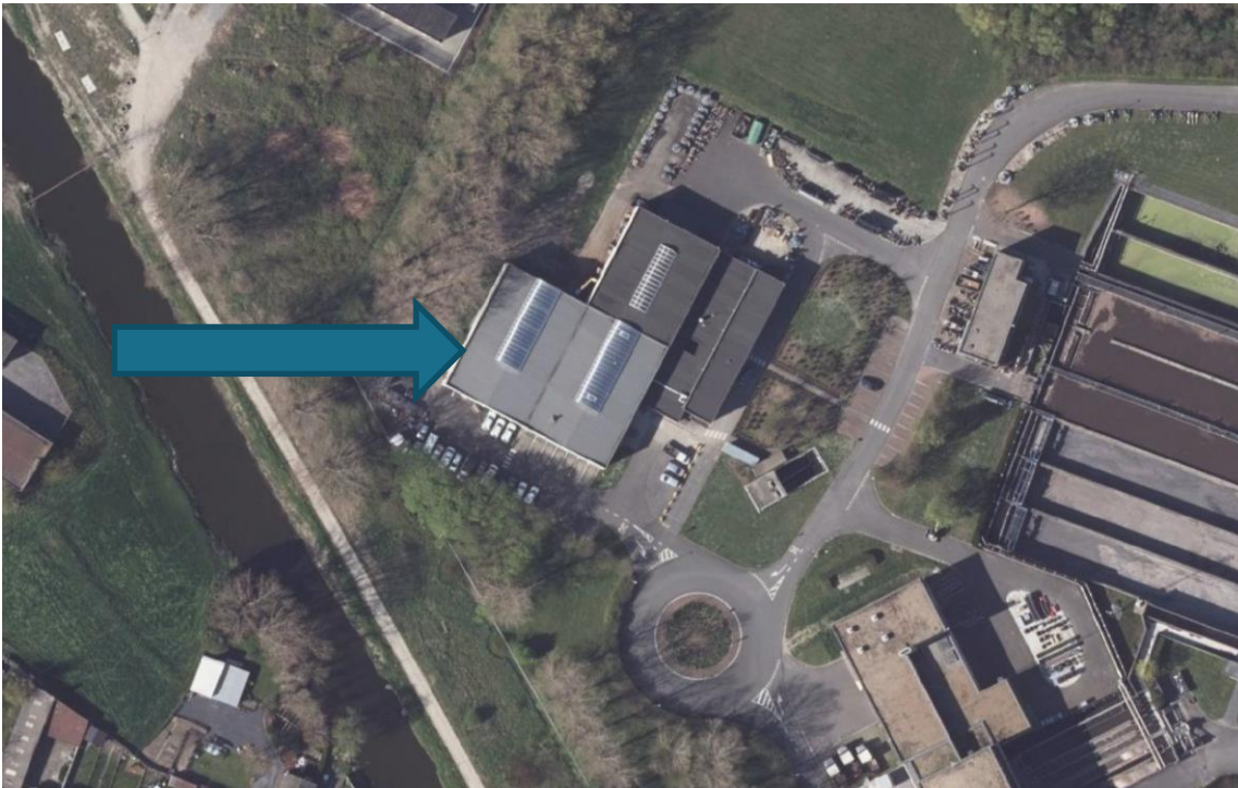
Figuur 1: Oostende onderhoudsdienst
