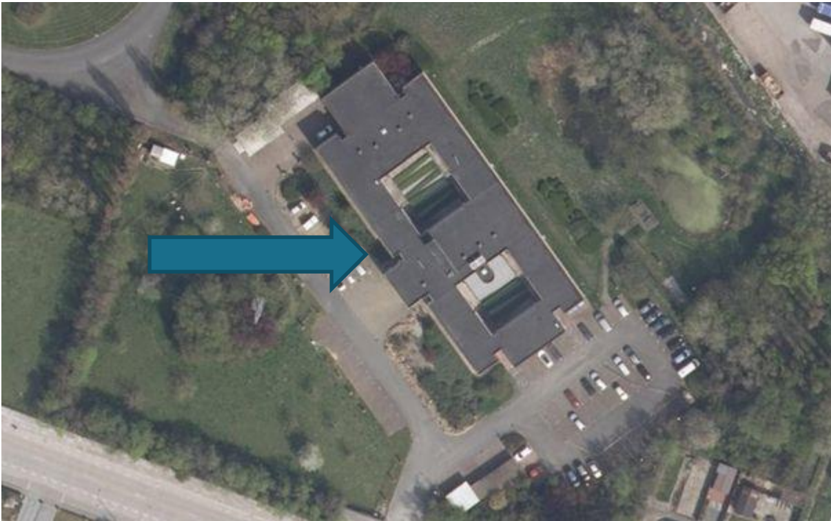
Figuur 1: VMM-gebouw Oostende (administratie)
