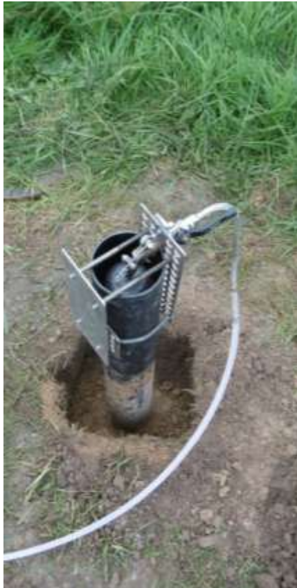
Foto 1: Geïnstalleerde meetcilinder met opgeschoven dispositief en aangesloten aanvoerslang.
